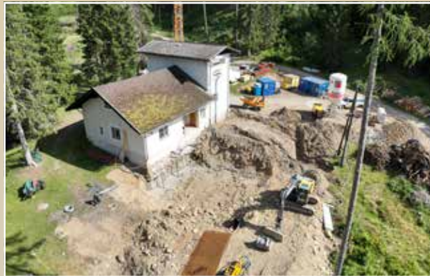
Aushubarbeiten für das neue Krafthaus
