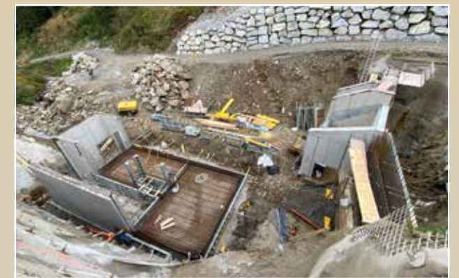
Querbauwerk (Wehr) und Entnahgebauwerk.
