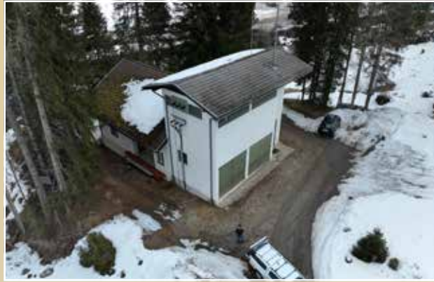
Krafthaus Bruggeralmkraftwerk vor Revitalisierung 2023
