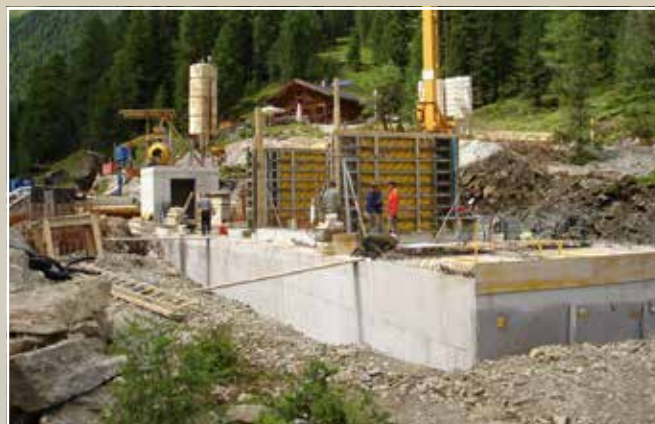
Bauarbeiten an der Wasserfassung
