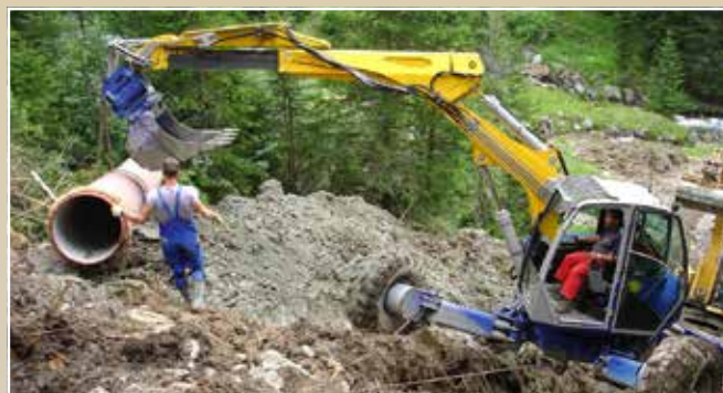
Verlegearbeiten der Druckrohrleitung
