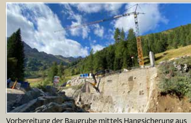
Vorbereitung der Baugrube mittels Hangsicherung aus Spritzbeton.
