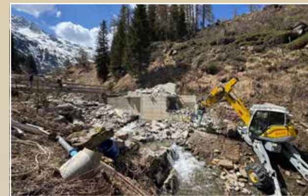
Abriss der alten Wasserfassung
