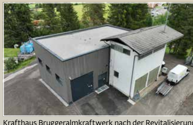
Krafthaus Bruggeralmkraftwerk nach der Revitalisierung 2026
