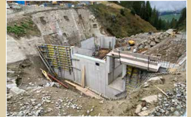
Neubau Wasserfassung Bruggeralmbach
