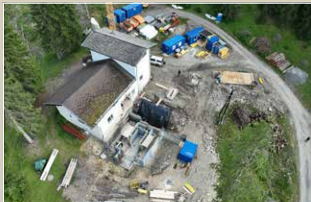
Revitalisierung Bruggeralmkraftwerk - Arbeiten am Krafthaus
