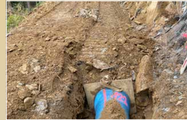
Arbeiten an der Druckrohrleitung
