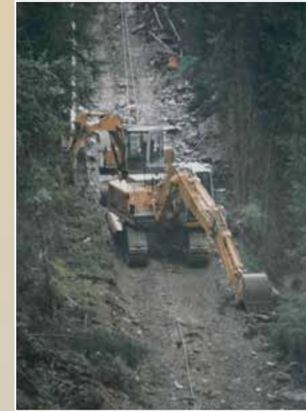
1999: Erneuerung der Druckrohrleitung Bruggeralmkraftwerk
