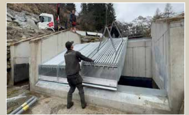
Einsetzen des Coanda-Rechens an der Wasserfassung
