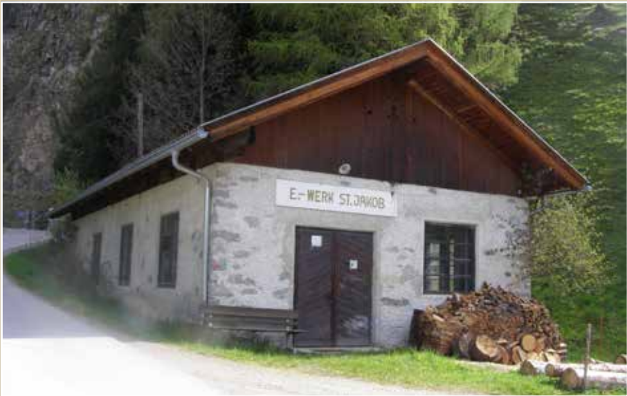
Im Bild das Wasserkraftwerk Trojeralmbach. Es wurde 1949 fertiggestellt und war bis zum 16. März 2005 in Betrieb.
