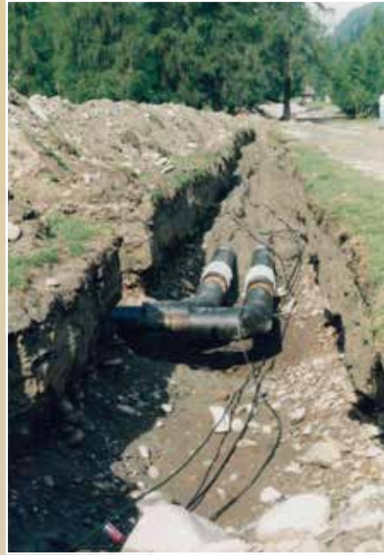
1994: Verlegung der Fernwärmerohre im Ortszentrum und auf Sander Ebene
