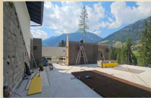
Neubau Krafthaus Bruggeralmkraftwerk
