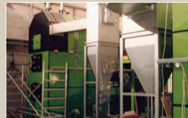
Biomassekessel 1 mit Staubabscheider (Multizyklon)
