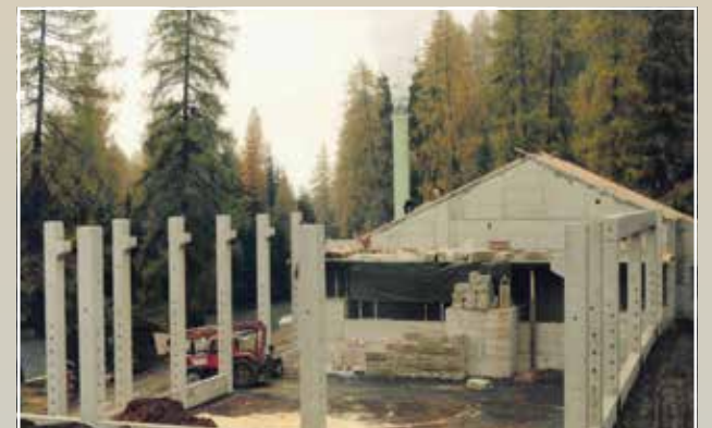
Mitten in den Bauarbeiten. Der Kessel läuft schon.
