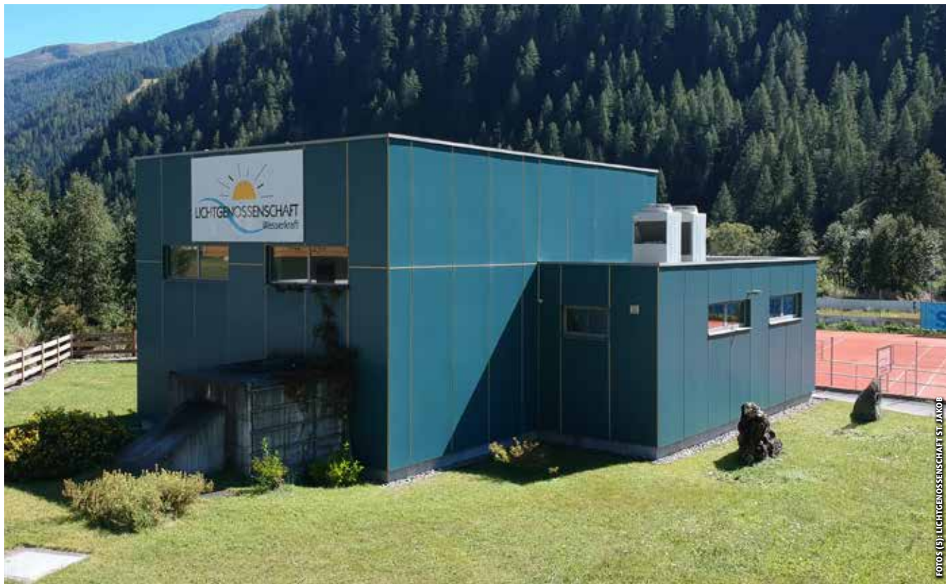
Aus der Kraft des Wassers des Trojeralmbaches wird in diesem Krafthaus Strom erzeugt und in das Netz der TINETZ eingespeist.
